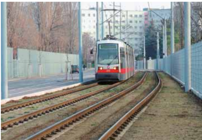
Abb. 5 Bauabschnitt 3: Grüngleis in der Oberfeldgasse
