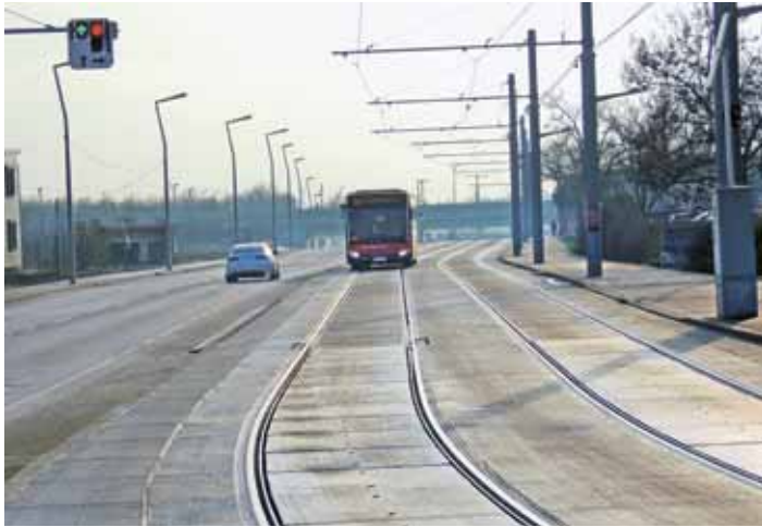
Abb. 7 Bauabschnitt 3: Selbstständiger Gleiskörper in der Hausfeldstraße
