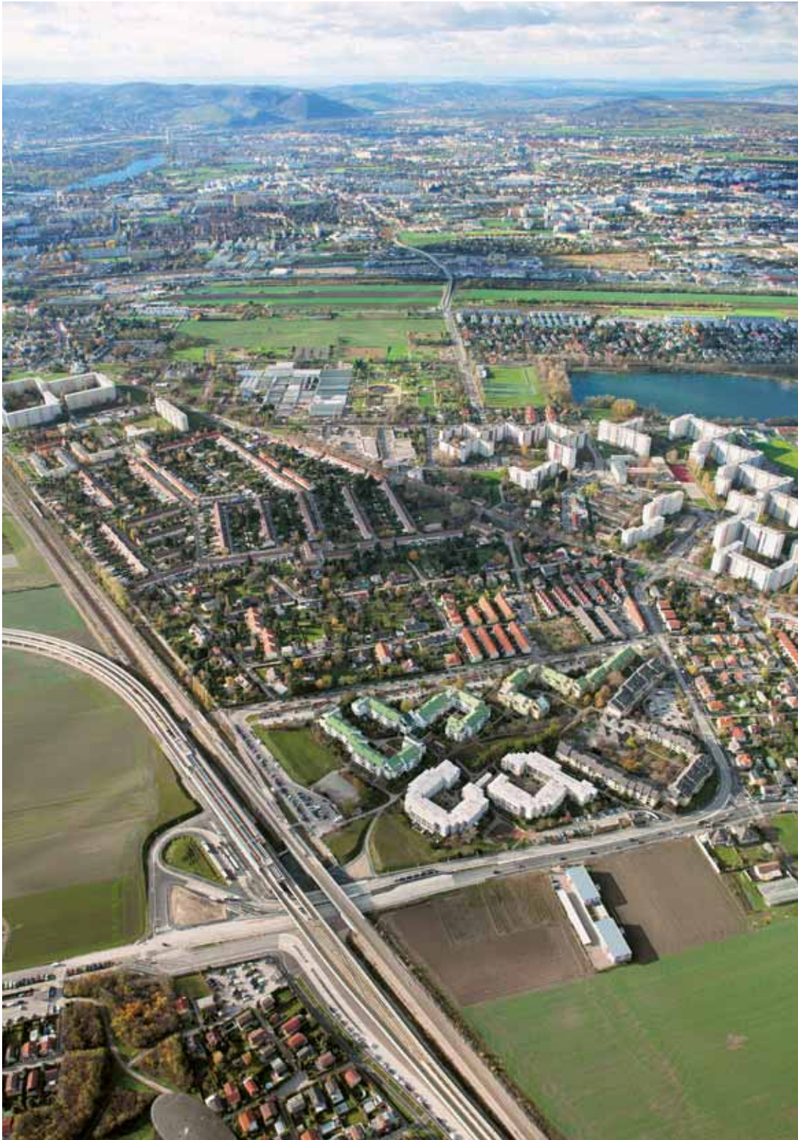
Abb. 6 Bauabschnitt 3: Blick von der Umkehrschleife Hausfeldstraße bis zum Kagraner Platz
