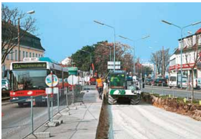
Abb. 9 Bauabschnitt 1: Zementstabilisierung im Bereich Kagraner Platz
