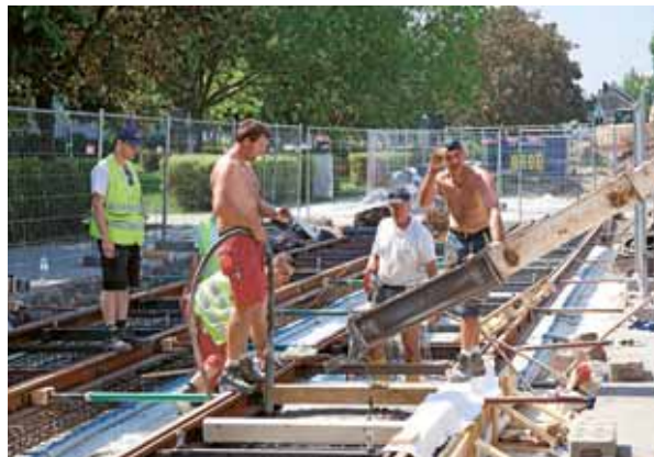
Abb. 10 Herstellung von Betonfeldern
