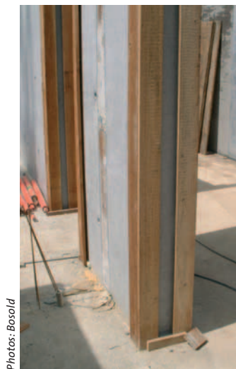
Vorbildlicher Kantenschutz bei einer Wandscheibe mit Abstandhaltern aus Schaumstoffresten im Bereich des späteren schwimmenden Estrichs, BV Leitstand Holcim in Dotternhausen, Ausführung Bau-Mauch
