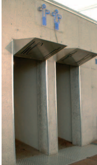
Kanten bei Sichtbeton mit eingelegten Profilen, Swarovski Kristallwelten, Wattens, Österreich
