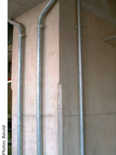
Stütze in einer Berufsschule in Karlsruhe. Kante bis zirka 2 m Höhe durch Dreikantleiste gebrochen
