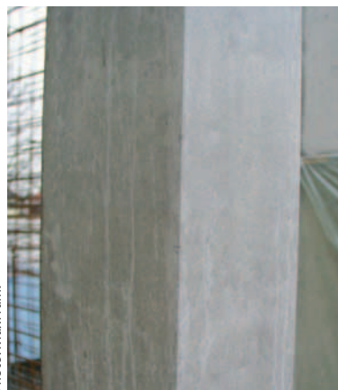
Einwegschalung – ausgeschaltete Stütze
