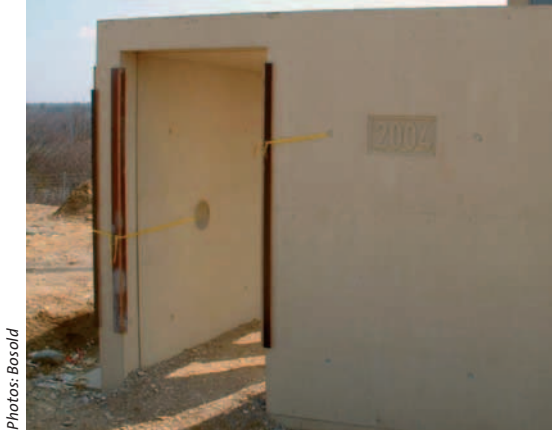
Schutzkonstruktion für eine scharfe Kante, Neubau Autobahnkapelle A 81, Hegau-West
