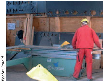
Schalhautzuschnitt auf der Baustelle, Mercedes-Benz Museum Stuttgart
