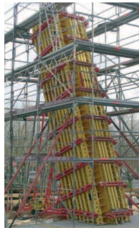
Verwindungssteife Schalung für schräge Stützen (Trägerschalung von Peri), Mercedes-Benz Museum Stuttgart
