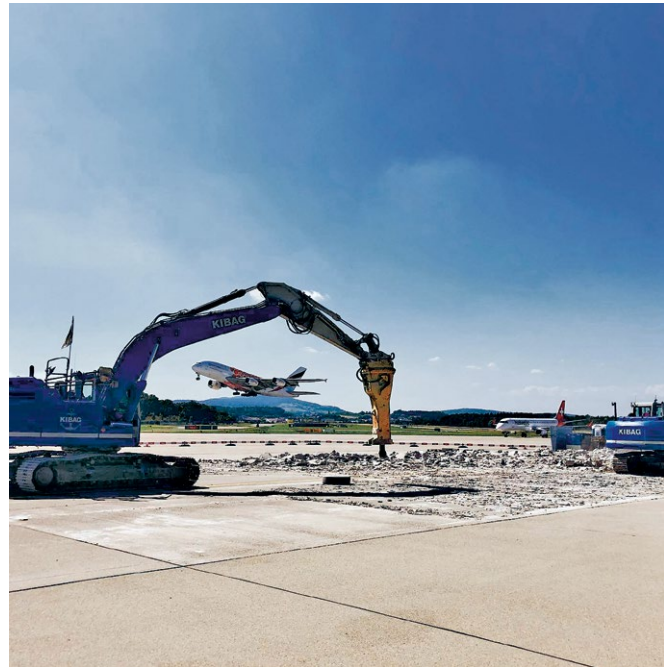
Abbruch bestehender Betonplatten
