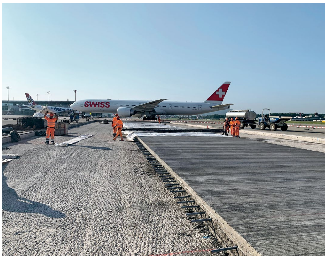
Nachbehandlung der eingebauten Stehbahn (Curing und anschliessendes Abdecken mittels Vliesmatten)
