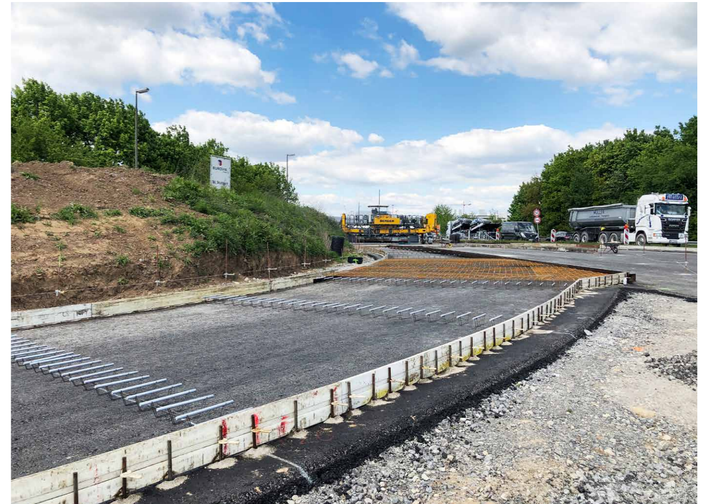
Vorbereitung Betondecke mit bewehrtem, geometrisch kritischem Feld; Vorlegen der Dübel in Körben unterhalb der späteren Querscheinfuge
