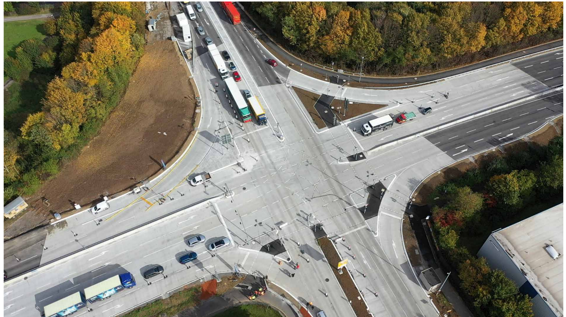
Luftaufnahme des fertiggestellten Daimler-Knotens nach der Betonage der letzten Bahn
