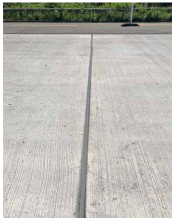
Fugenverguss: Herstellen der zweikomponentigen Kaltfugenvergussmasse auf Polysulfidbasis
