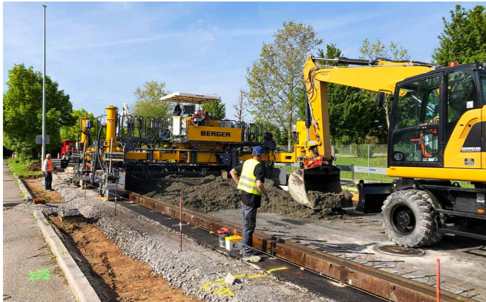
Das erste «Anfahren» unter Produktion des Straßenbaufertigers ist immer spannend und wurde mit Bravour vom Bedienungs- und Einbaupersonal gemeistert.
