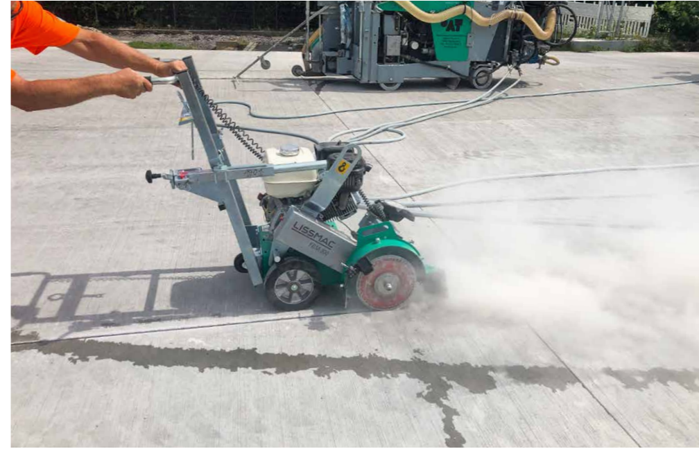
Fugenschnitt: Im Vordergrund Einfräsen der Voute (Abfasen). Im Hintergrund die Aufsitzschneidemaschine für den zuvor erstellten ersten und zweiten Fugenschnitt (1. Fugenkerbe, 2. Fugenspalt)
