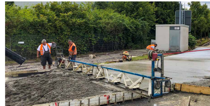
Betoneinbau mit der Rüttelbohle in der Konsistenzklasse F3
