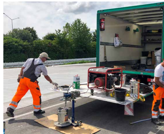
Fugenverguss: Herstellen der zweikomponentigen Kaltfugenvergussmasse auf Polysulfidbasis
