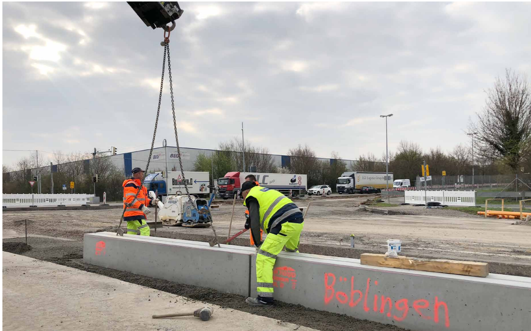
Tiefbauarbeiten, neue leistungsfähigere Straßenentwässerung
