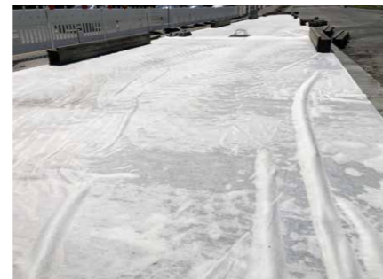
Zusätzliche Nachbehandlung mit wasserhaltendem Vlies
