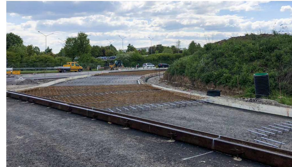
Positionierung der Dübel in Körben, bewehrte geometrisch kritische Felder
